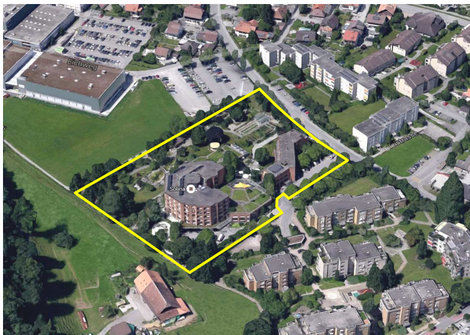
► Übersicht Anlage Solina Steffisburg
