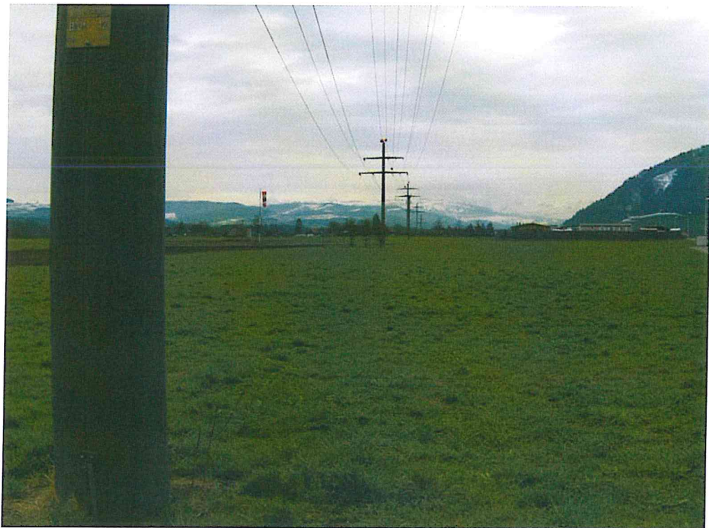
Bereich BKW – Leitung Blickrichtung Süd
