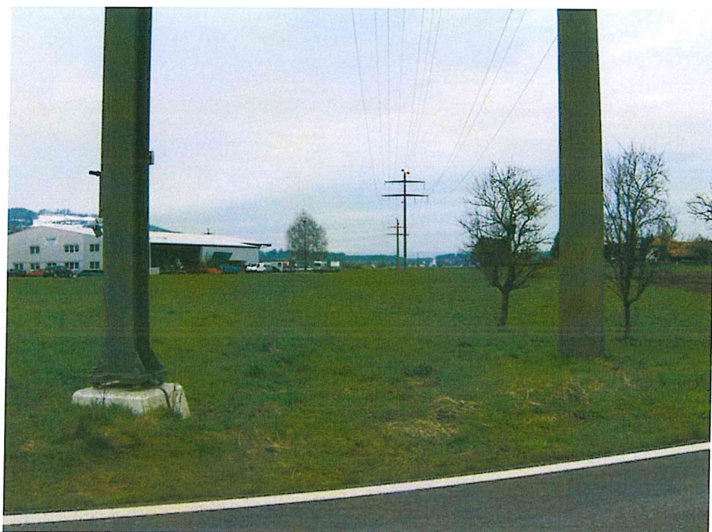
Bereich BKW – Leitung Blickrichtung Nord
