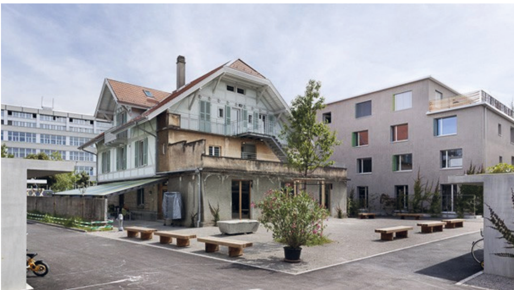
Referenzbild Integration Altbau in neues Gefüge; © Siedlung Burgunder, Bern
